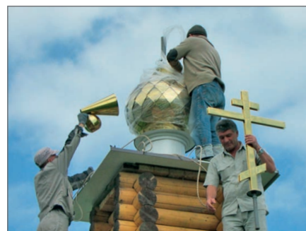
Строительство нового храма в селе Тыловой. 10 июля 2014 года.
