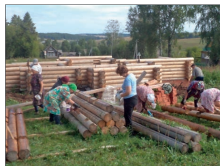
Строительство нового храма в селе Тыловой.
