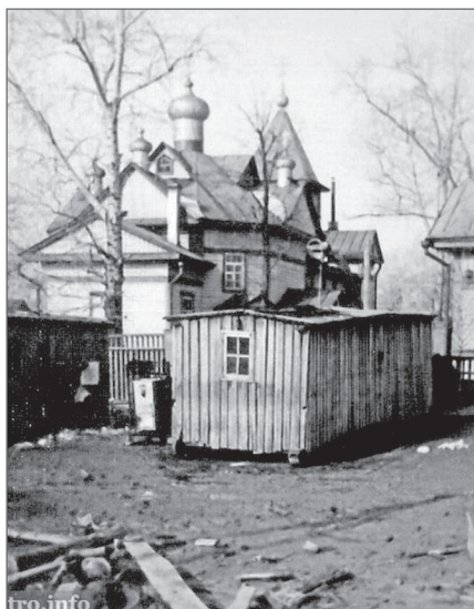
Георгиевская церковь перед сносом. 8 апреля 1962 года.
