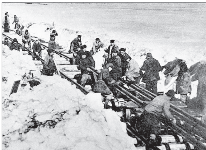
Строительство железной дороги Воркута-Котлас в Коми АССР. 1941 год.
