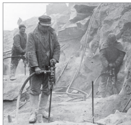
Заключённые Сорокского лагеря НКВД на строительстве железной дороги. 1940 год. Фото из Государственного архива Российской Федерации.
