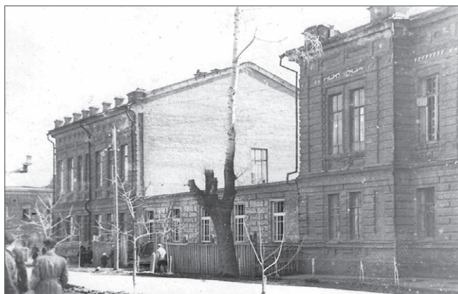
Строительство перемычки между школами №1 и №9. 1961-1962 годы.
