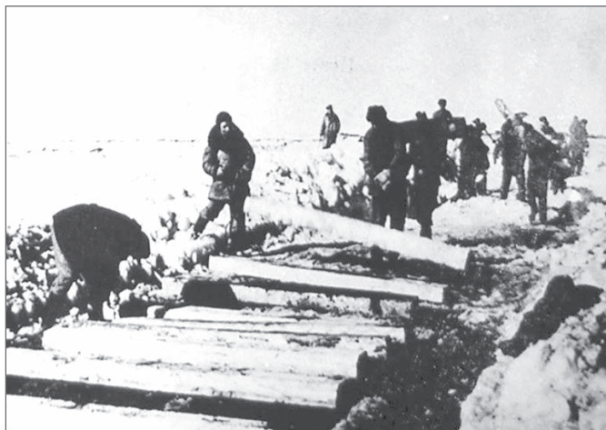
Заключенные Северного ж.д. ИТЛ на строительстве железной дороги Котлас-Кожва. 1940 г. Из коллекции НМ РК.
