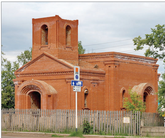
Строящийся храм в селе Юкаменском. 28 июня 2014 года. Фото Юрия Дерябина.
